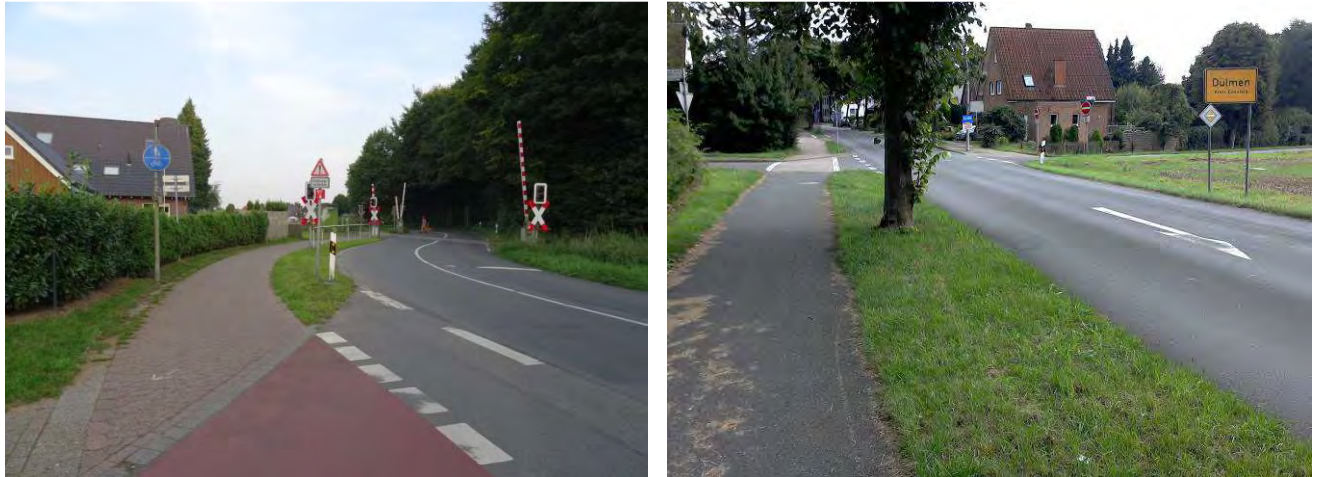
Bild 19: Außerörtlicher Streckenabschnitt (Untersuchungsnetz), Borkener Straße
