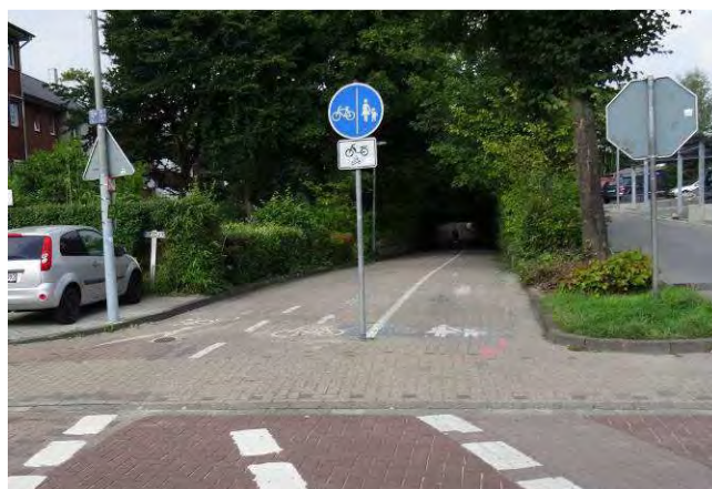
Getrennter Geh- und Radweg im Zweirichtungsverkehr zwischen Alter Ostdamm und August-Schlüter-Straße
