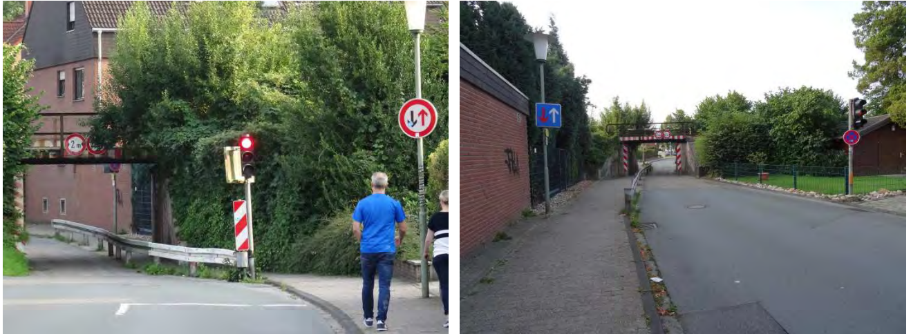
Bild 69: Engstelle auf Höhe der Bahnunterführung Haverlandweg aus Richtung Norden (links) und Richtung Süden (rechts)
