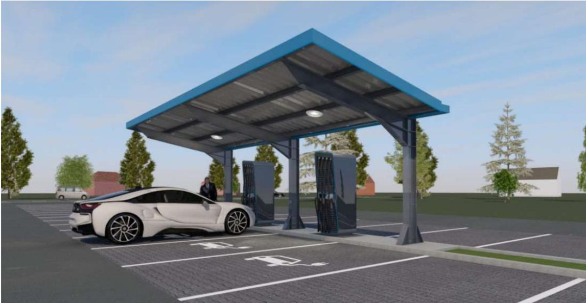
Abbildung 46: Modell E-Ladepark mit PV-Überdachung (Quelle: Siebe 2021)
