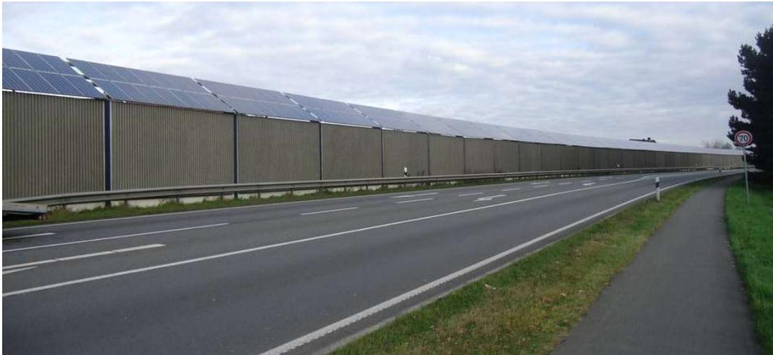
Abbildung 44: PV-Anlage an einer Lärmschutzwand in Wietmarschen (Quelle: Gemeinde Wietmarschen )
