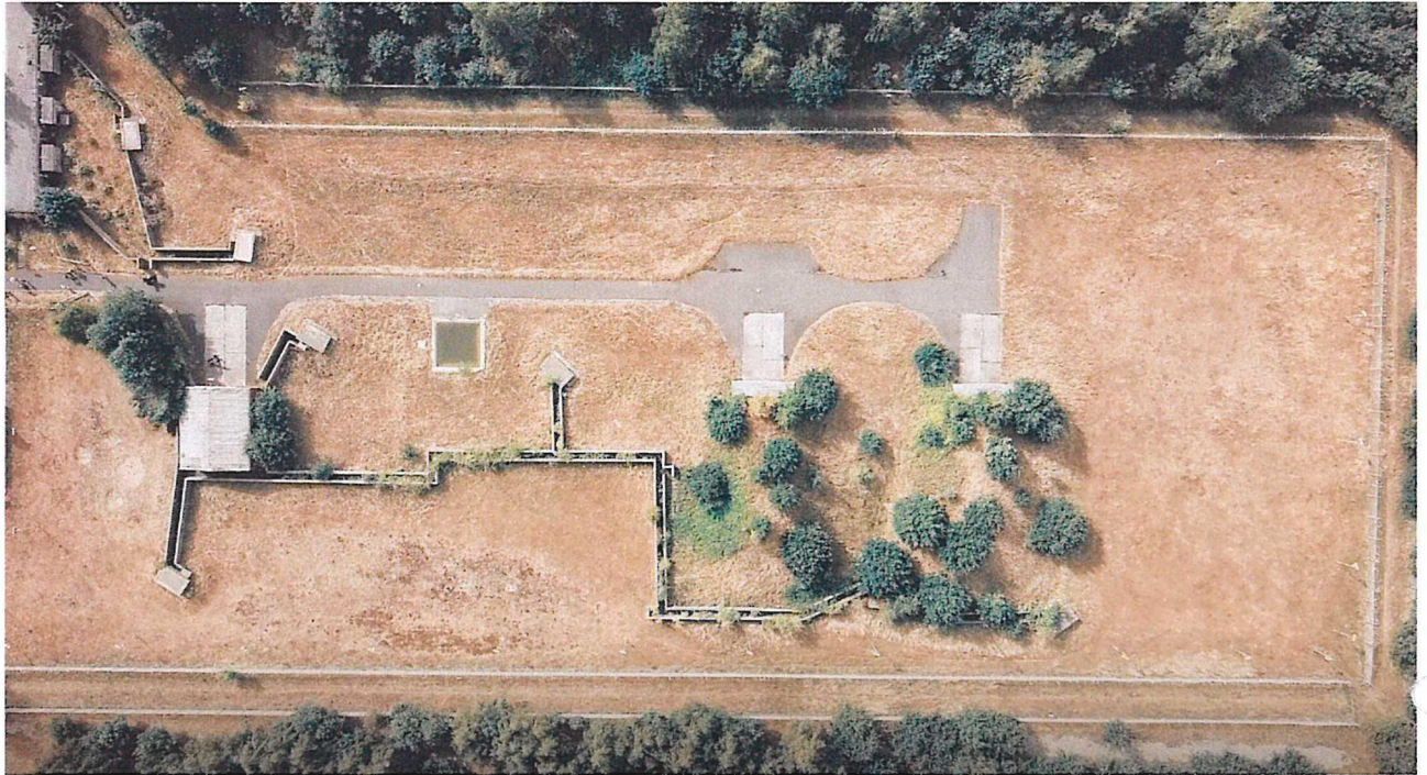
Aufsicht auf das Stellungssystem im Inneren Sperrbereich
