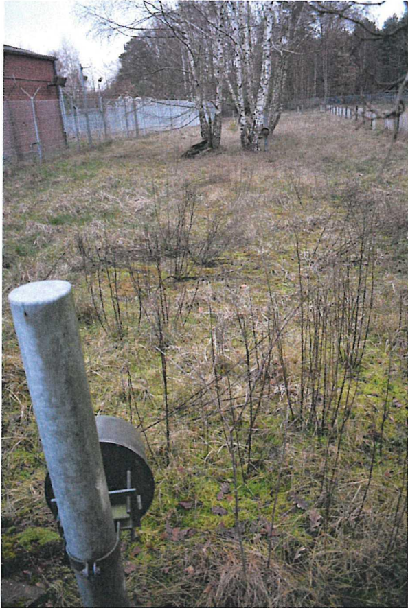
Bewegungsmelder der NIDS-Anlage innerhalb der "Clear Zone" (Sondermunitionsdepot) Aufnahme: LWL-DLBW, Anke Kuhmann 01/2019
