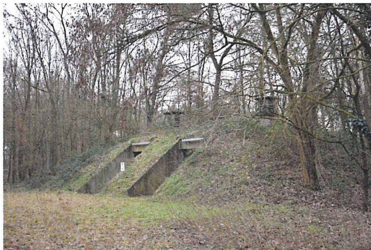
Munitionslagerhaus als Doppelbunker (Standortmunitionsniederlegung) Aufnahme: LWL-DLBW, Anke Kuhmann 01/2019
