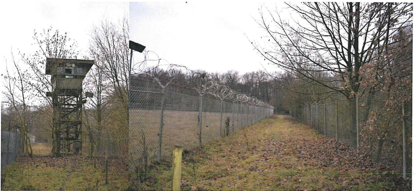
Wachturm CHARLY und „Controlled Area“ zwischen der inneren Doppelzaunanlage (Sondermunitionsdepot)
